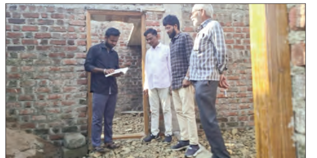
ఇందిరమ్మ ఇళ్ల నిర్మాణ పనులను పరిశీలిస్తున్న హౌసింగ్ ఏకా
